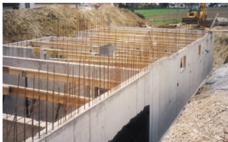
Bild 4 • Erstellung des Kellergeschosses
