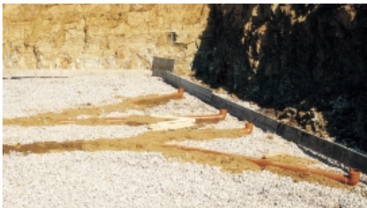
Bild 2 • Grundleitungsverlegung
