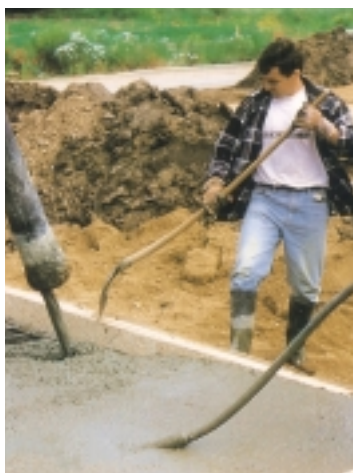
Bild 3 • Betonieren der Bodenplatte
